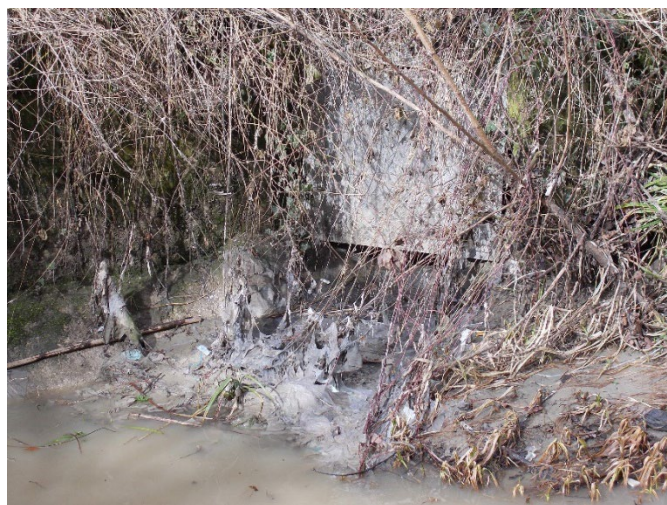
Photo 1 : Présence de papier de toilettes et de déchets de type eaux usées au niveau du déversoir d'orage
